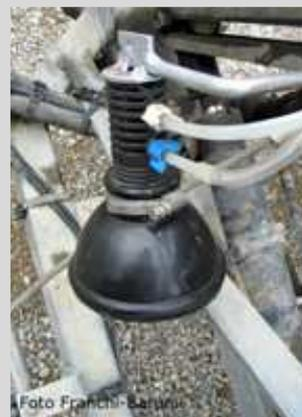
Foto 25 – Congegno miscelatore-spruzzatore del liquido schiumogeno.
