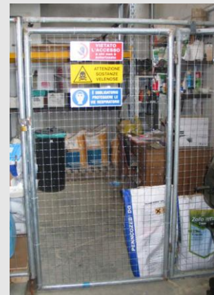
Apposito recinto munito di porta e serratura, all'interno del magazzino (Foto Cons. Fito. Reggio Emilia)
